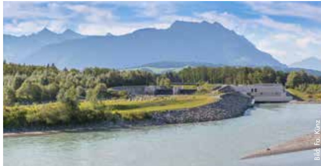
Ansicht Unterwasser (Rhein)
