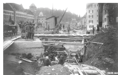
Bau des Verbindungskanals 1924
